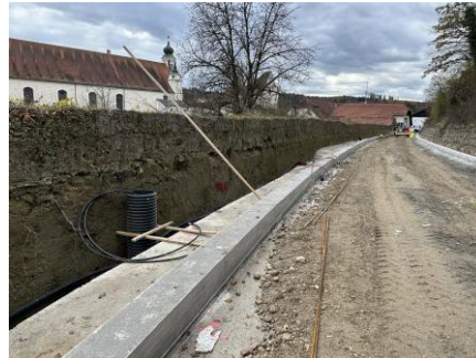
Sicherung und Sanierung Hirschgartenmauer mit Schwerlastmauer im Straßenkörper
