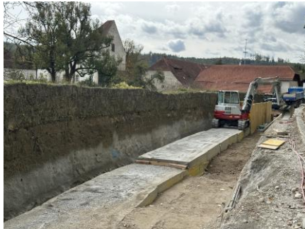
Sicherung und Sanierung Hirschgartenmauer mit Schwerlastmauer im Straßenkörper
