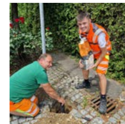
Pflastersteine raus, Halterung rein: Gemeinsam mit seinem Kollegen Sven betoniert Straßenwärter-Azubi David Brücker (re.) den Sockel für ein neues Straßenschild ein
