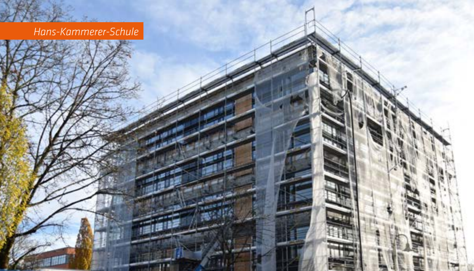
Die meisten Arbeiten an der Hans-Kammerer-Schule sind abgeschlossen. Bald ist nicht nur die Außenfassade des Erweiterungsbaus ohne Gerüst zu bewundern, sondern auch der neu gestaltete Pausenhof
