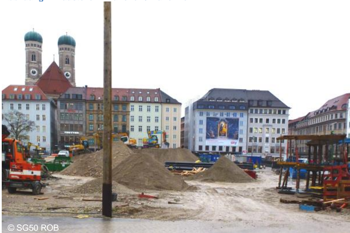
Abbildung 1: Baustelle in München / Marienhof
