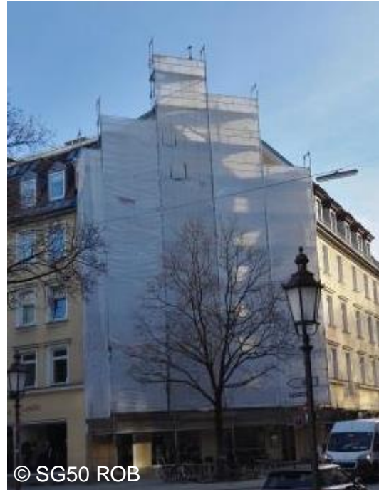
Abbildung 4: Einplanung eines Gerüsts
