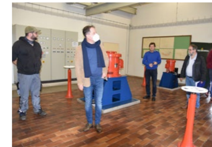
Besichtigung des Pumpwerks zeigt spannende Einblicke in die Funktion von Salzlände und Werk.
