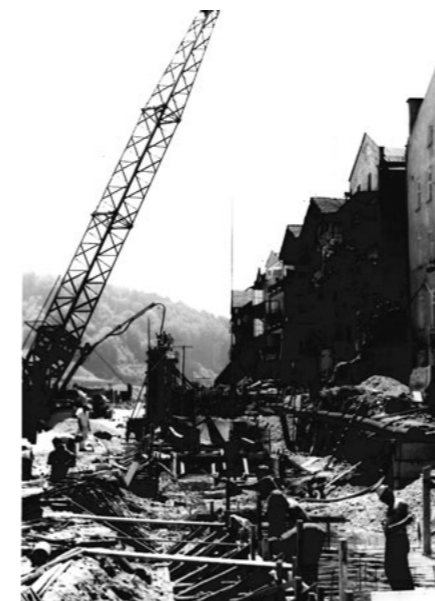
Zwischen 1968 und 1970 wurde die Uferstraße mit dem unterirdischen Sickerang gebaut. Seit 2016 - mit Errichtung des zusätzlichen Hochwasserschutzes auf der Salzländenmauer - steht die Stadt Burghausen für den Unterhalt der Salzlände in der Verantwortung.
