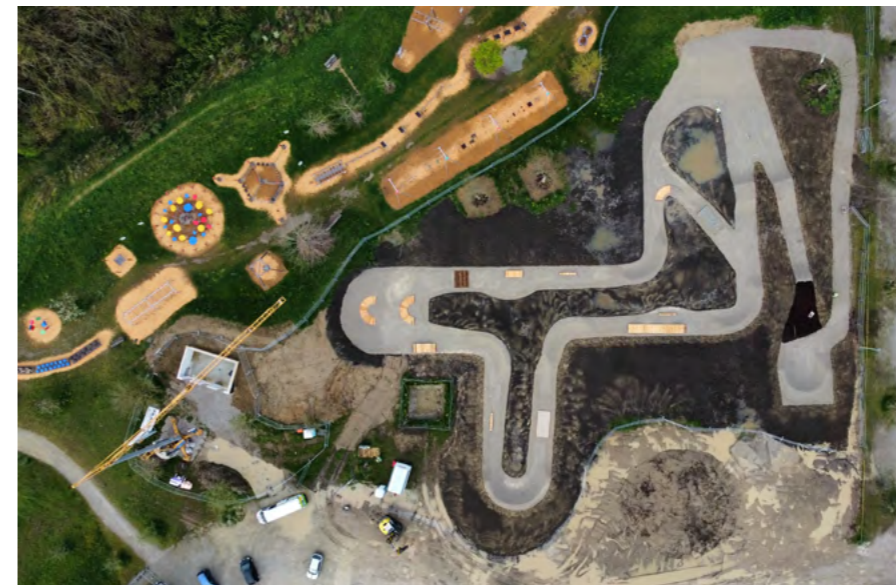
Täglich im Visier. Die vhs-Fotogruppe Burghausen dokumentierte die Baufortschritte des Bikeparks am Waldpark jeden Tag mit der Drohne. Danke für die tolle Zusammenarbeit.
