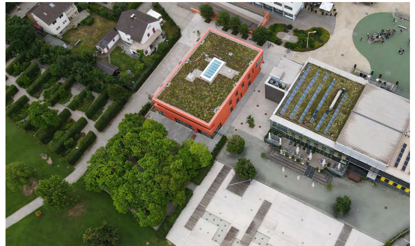
Die Temperaturen steigen v.a. in den Innenstädten massiv. Städteplaner raten daher zur Dachbegrünung, denn je mehr Grün und Bewuchs in der Stadt, umso milder der Temperaturanstieg. Auf dem Bürgerhaus und dem Haus der Familie in Burghausen.
