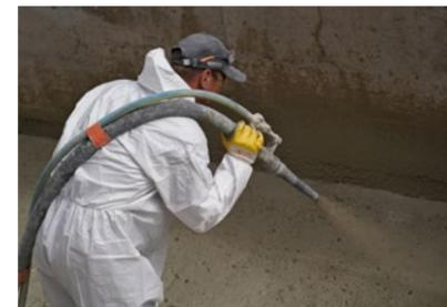
Mit Wasserkraft wird die angegriffene Betonschicht im ersten Bauabschnitt entfernt.
