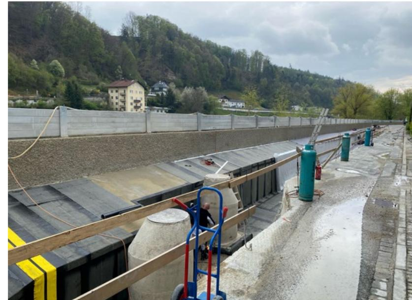
Das Bitumenabdichtungsmaterial wird auf den Sickergraben und die Auskragung der Ufermauer aufgebracht. Die Abdichtung stellt den Schutz vor Chlorideintrag dar.
