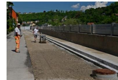
Verfüllung des Sickergraben-grabens mit Aushubmaterial.
